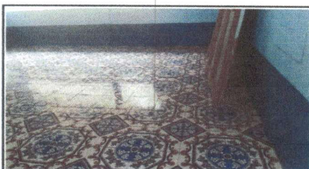
Foto 6: Sustitución de piso cerámico (dirección, aula 1 y 2)
