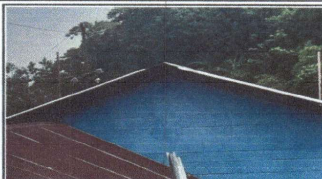
Foto 2: Sustitución de capote de lámina para lámina troquelada aluzinc calibre 26 (dirección, aula 1 y 2)
