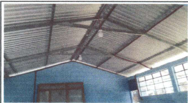
Foto 9: Instalación de unidades de fuerza (focos, tomacorriente, interruptor, flipon, incluye cable eléctrico (dirección, aula 1 y 2)
