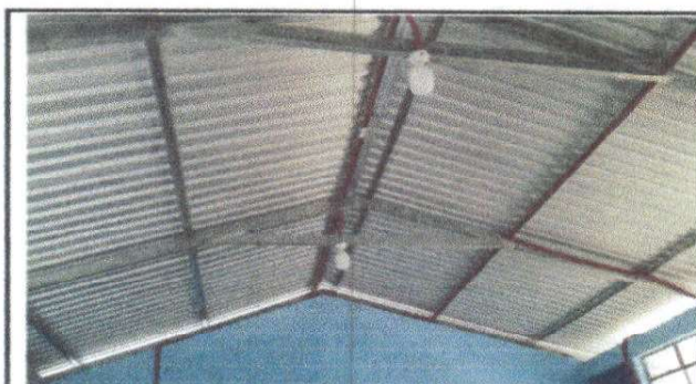
Foto 4: Sustitución de estructura de soporte de metal por metal (dirección, aula 1 y 2)
