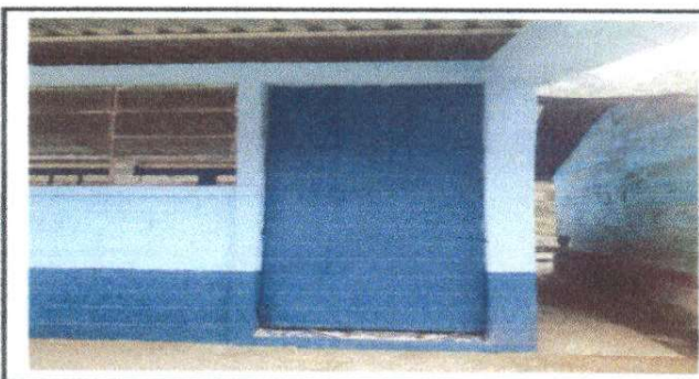
Foto 5: Mantenimiento a estructura de puerta (lijado, pintado) (aula 1 y 2)
