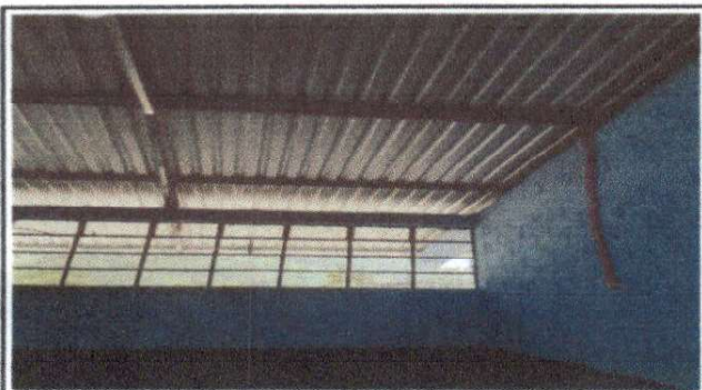
Foto 7: Pintura de muros interiores (dirección, aula 1 y 2)
